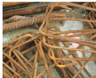
ภาพที่ 1.8 การเกิดสนิมของเหล็ก ที่มา : http://www.oknation.net/civil/2008/09/06/entry-2
